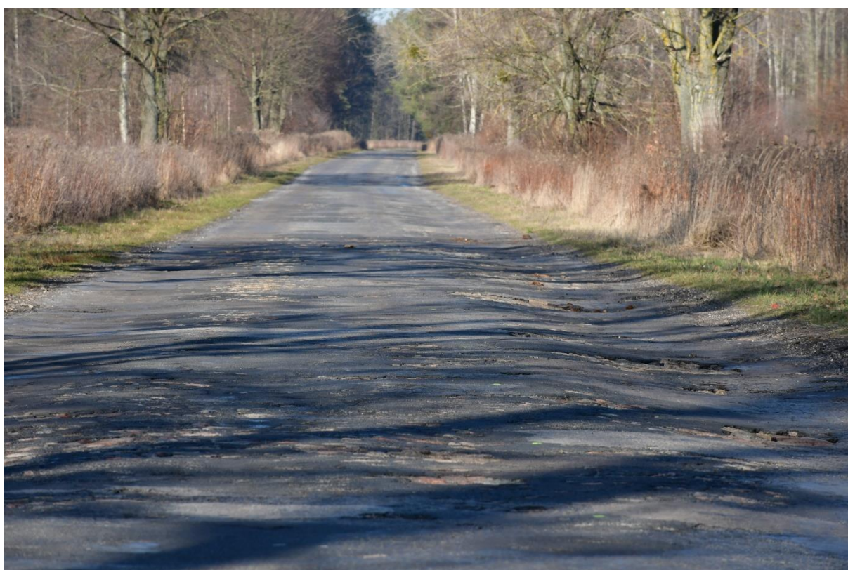
Droga w Kotlinach przed remontem
