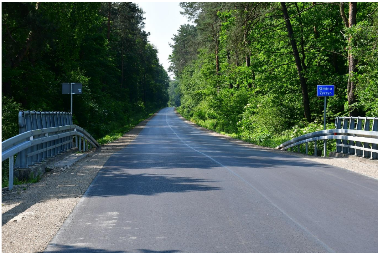
Droga w Kotlinach po remoncie
