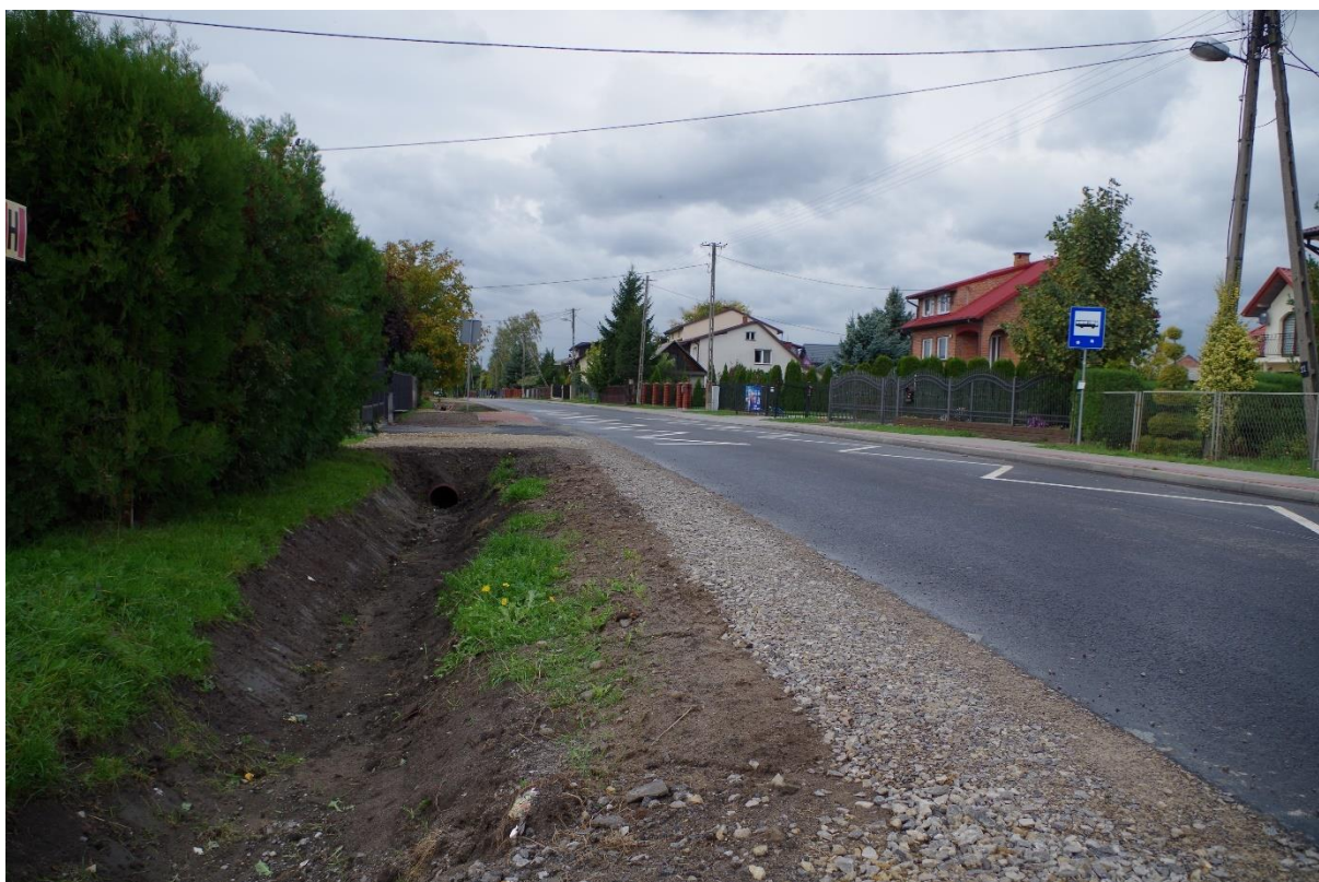
Droga po remoncie – ulica Centralna
