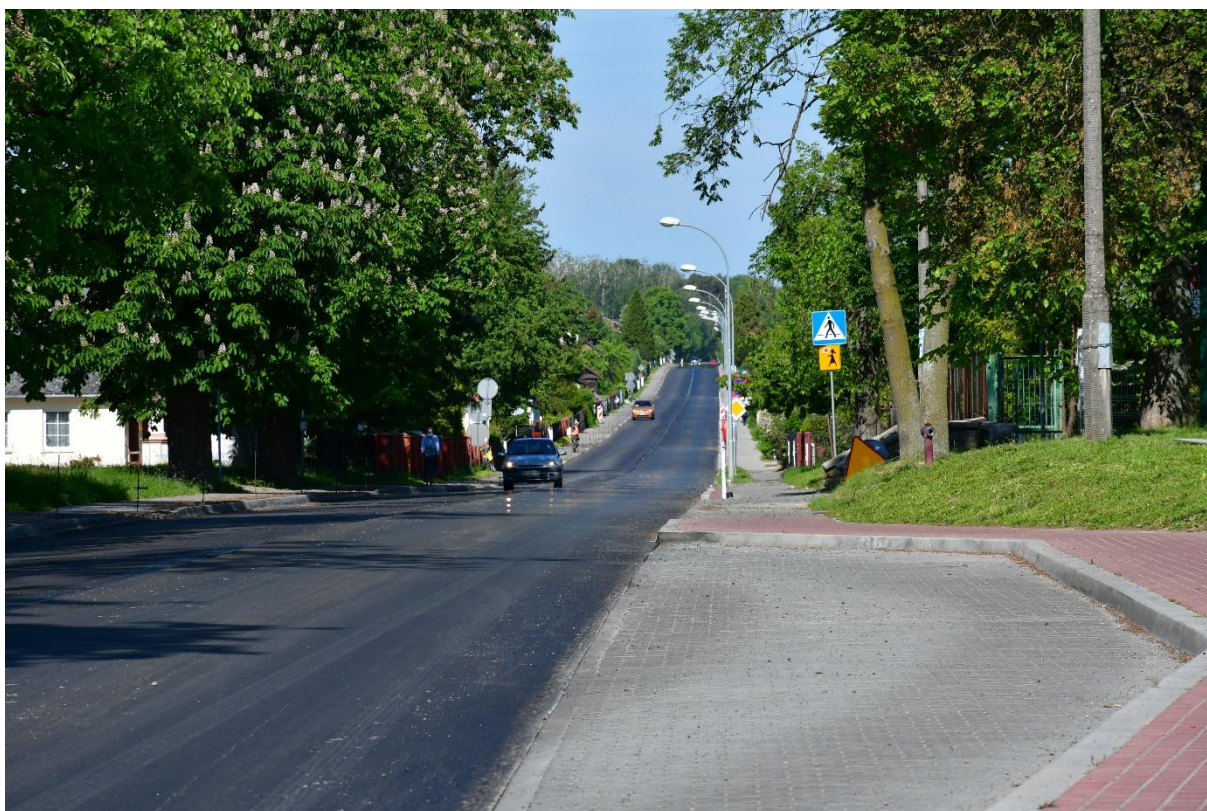
Ulica Tysiąclecia w Żyrzynie po remoncie
