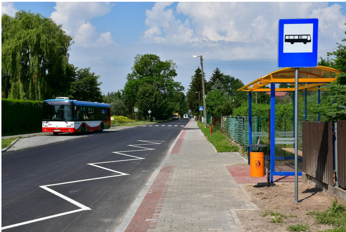
Ulica Tysiąclecia w Żyrardowie po remoncie
