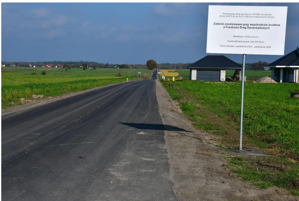
Droga po przebudowie
