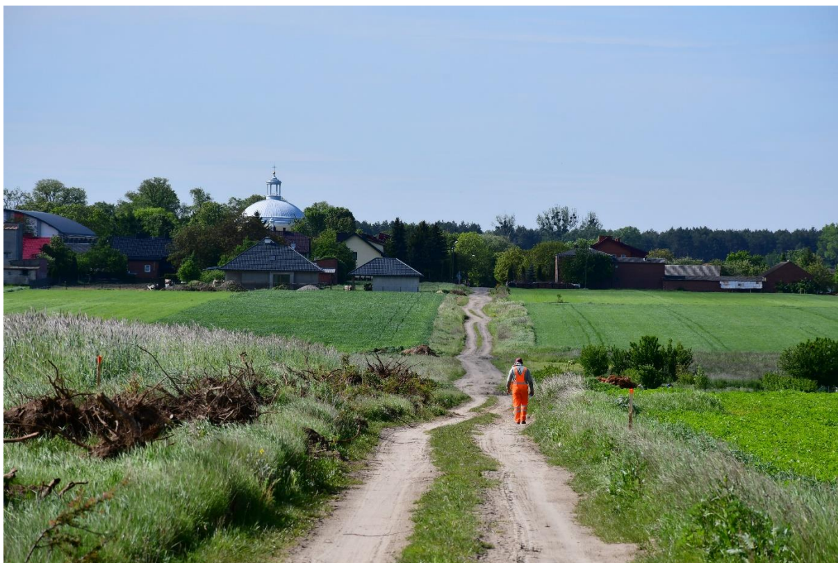
Droga przed przebudową
