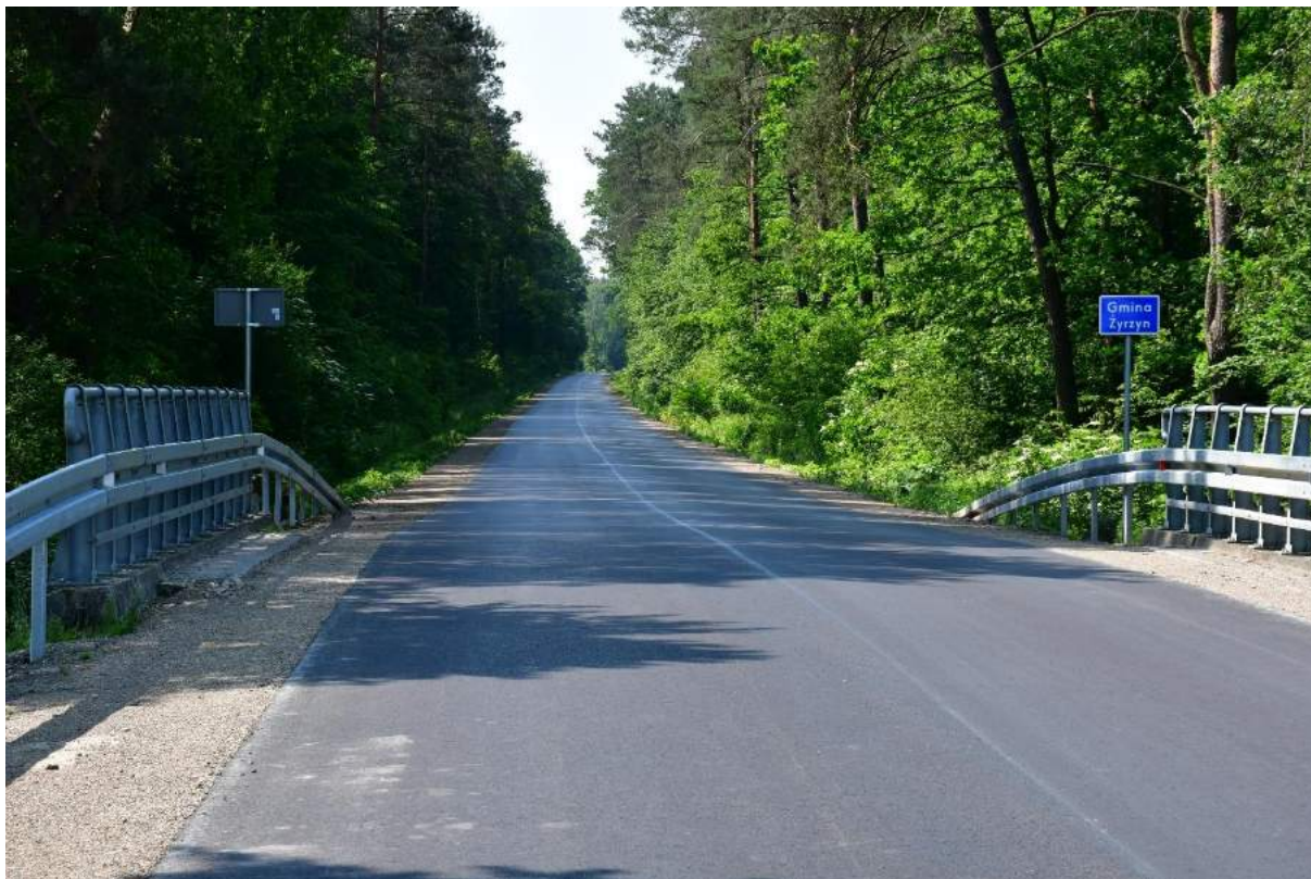
Droga w Kotlinach po remoncie
