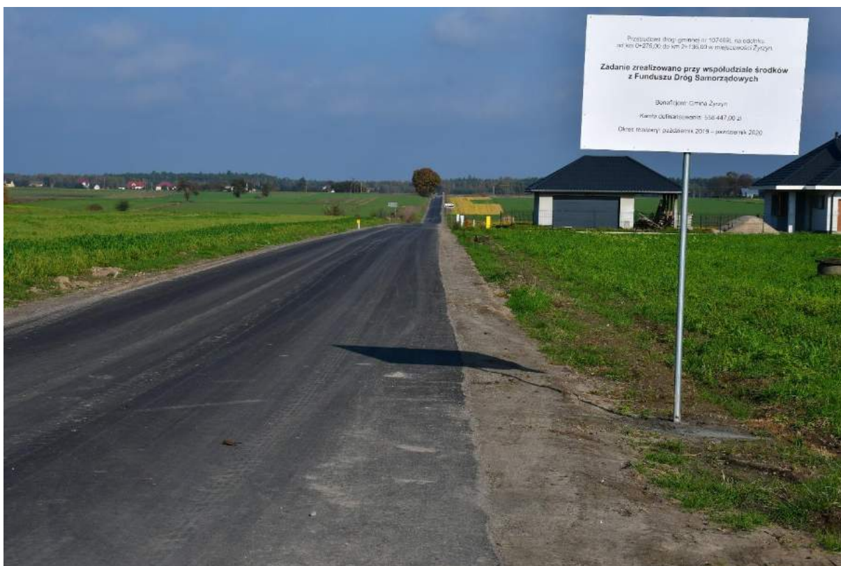
Droga po przebudowie
