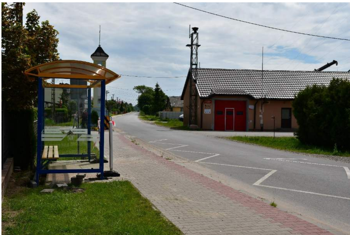
Droga po remoncie stanowi drogę gminną – ulica Centralna
