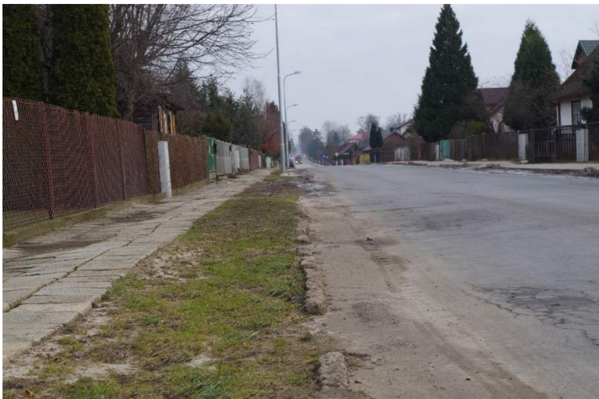
Ulica Tysiąclecia w Żyrzynie przed remontem
