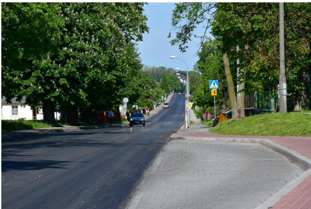
Ulica Tysiąclecia w Żyrzynie po remoncie
