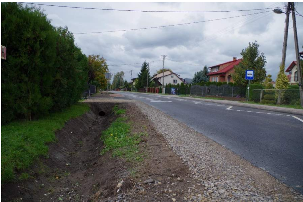
Droga po remoncie – ulica Centralna
