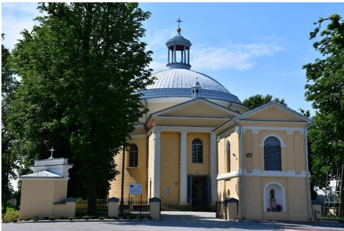
Kościół po rewitalizacji
