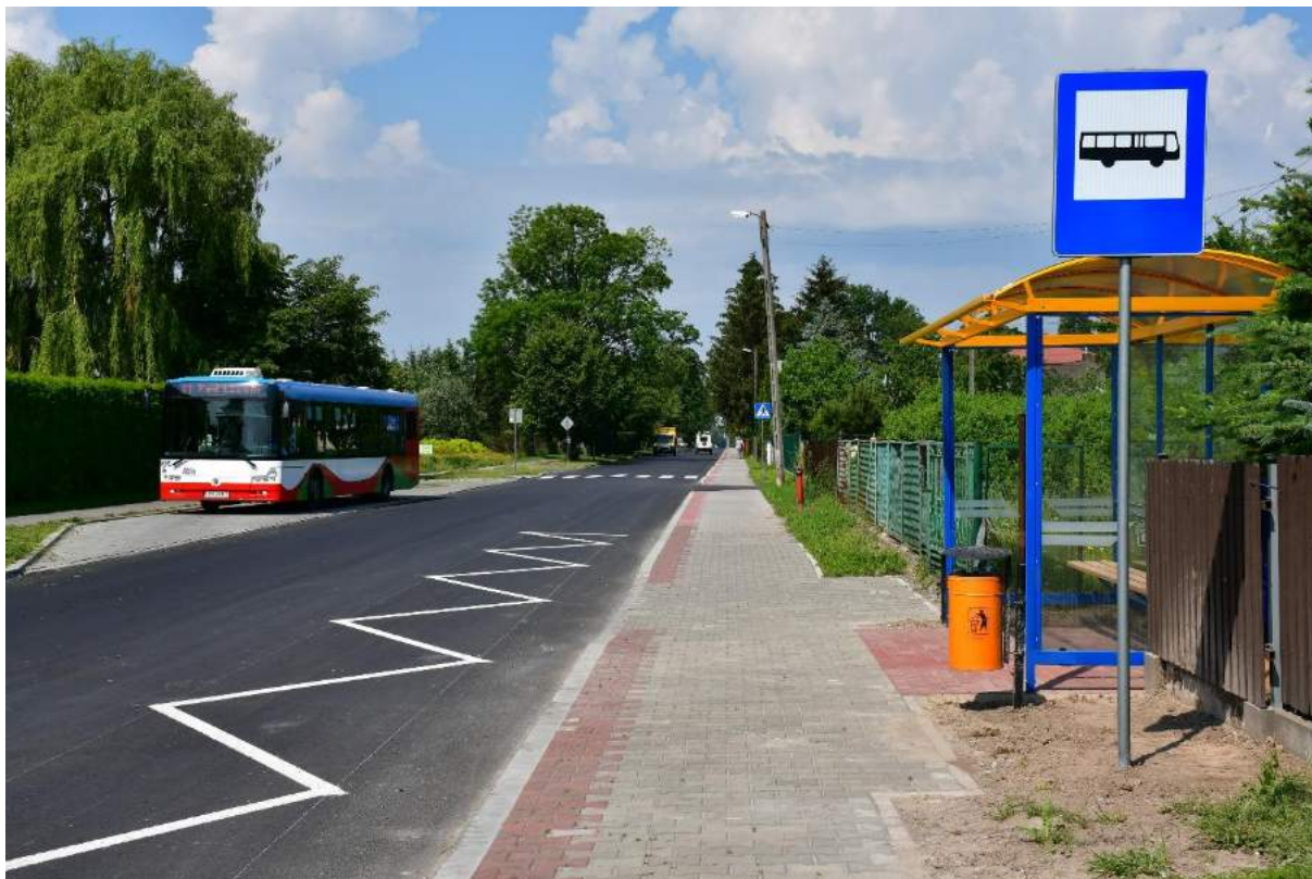
Ulica Tysiąclecia w Żyrardowie po remoncie
