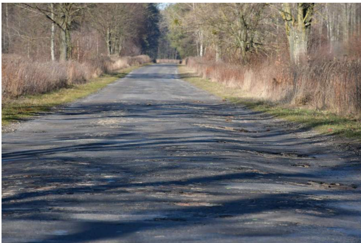
Droga w Kotlinach przed remontem
